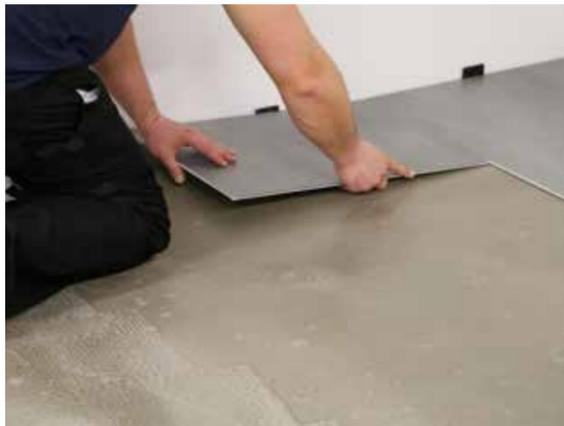
Continuare a installare le piastrelle della seconda fila. È importante controllare che le prime due file siano dritte e allineate in quanto da queste due file dipende tutta la posa.
