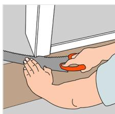
Türzargen aus Holz sollten gekürzt werden, um Platz für Belag und Unterlagsmaterial zu schaffen. Legen Sie ein Element oder einen Abschnitt umgekehrt auf den Untergrund. Nutzen Sie so die Paneeldicke, um die Zarge passgenau abzusägen. Beim Verlegen achten Sie auch unter der Zarge unbedingt auf 8-10mm Abstand!
