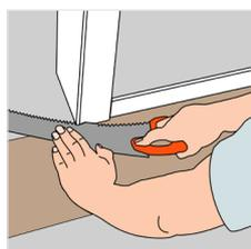
I telai in legno delle porte vanno accorciati abbastanza da poterci infilare sotto una doga con il relativo materassino. Posate un doga dal lato rovescio accanto al telaio della porta. Segate la doga e fatela passare sotto il telaio della porta. Mantenete uno spazio di dilatazione di 8-10 mm, sotto il telaio della porta!
